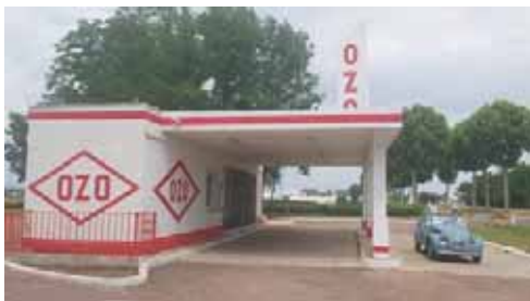
Sur la route du retour, la station OZO du Coteau, non loin de Roanne
